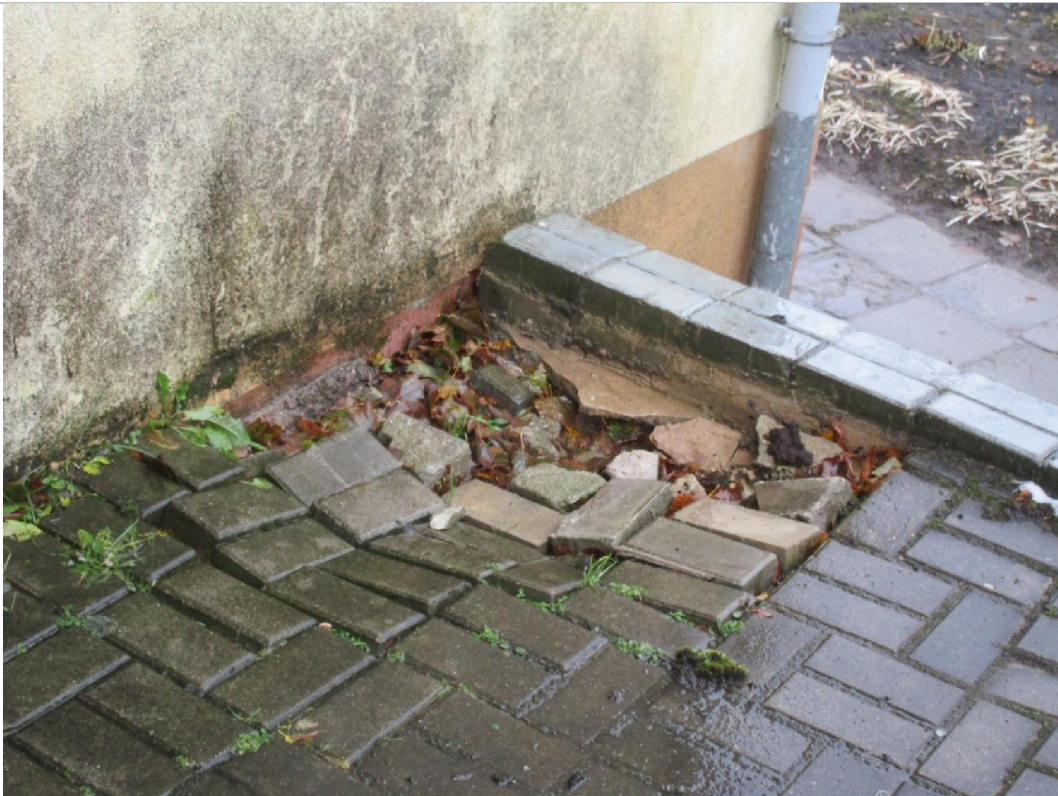
Konstatējams, ka platforma ar bruģakmens iesēdumu.
