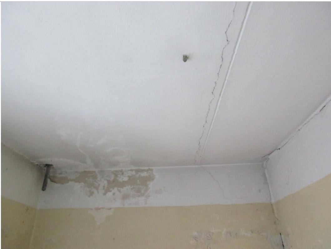
Plaisas pārseguma paneļu šuvju vietās.
