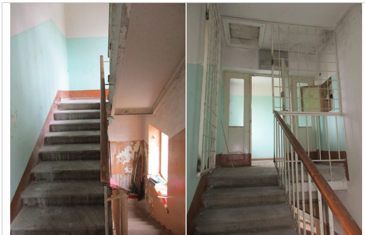
Metāla siju nesošā konstrukcija, industriāla izgatavojuma dzelzsbetona kāpņu laidī un starplaukumi, laukumi.
