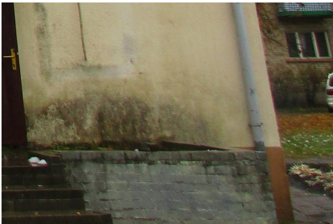
Mitrumpiesātinājums virs D ieejas lieveņa platformas.
