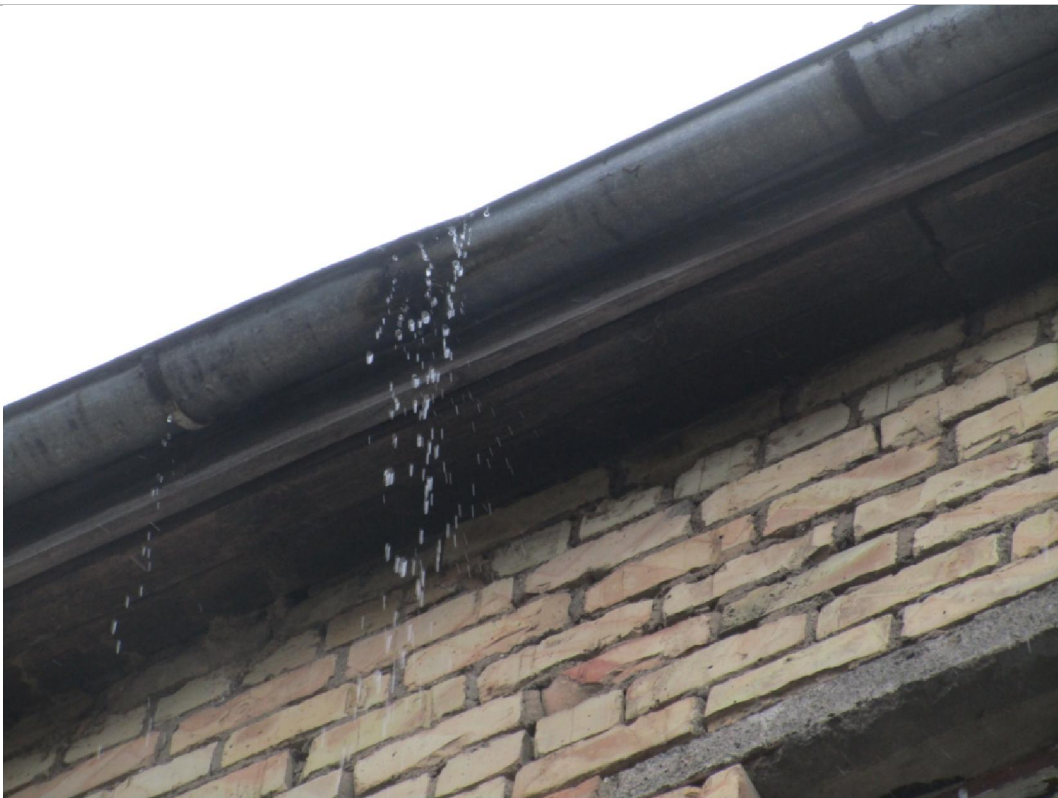
Lietus ūdens novadsistēmas elementi ar korozijas uzslāņojumiem, nehermētiskiem posmu savienojumiem, demontētiem posmiem, bioloģisku aizsērējumu.
