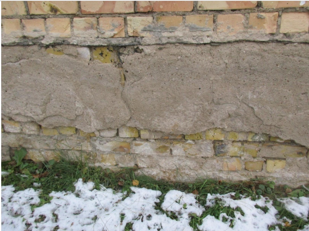
Apmetuma nobrukums un mūra šuvju izskalojums.
