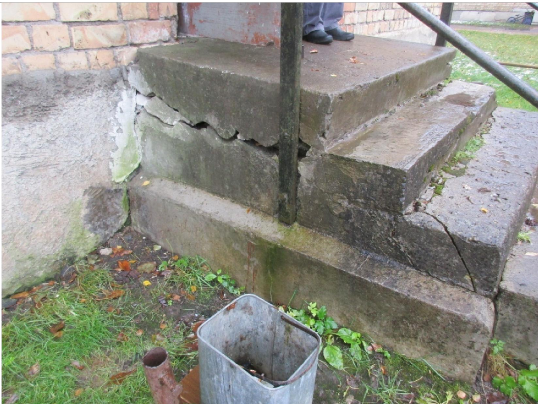
Ēkas Z un D gala fasādēs monolīta betona pakāpienu un platformas lieveņi.
