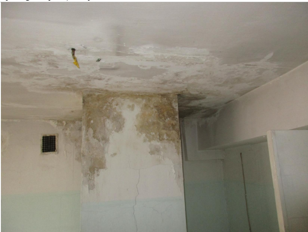
Caurtecējumu plankumi griestu plaknē, ap ventilācijas šahtu.
