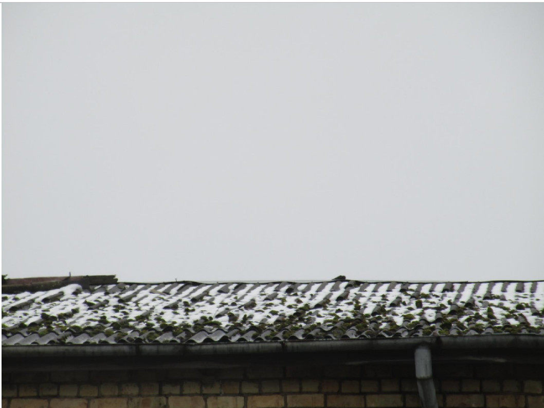
Jumta plakne ar ieliekumu dēļ spāru liela laiduma bez atbalsta konstrukcijas.
