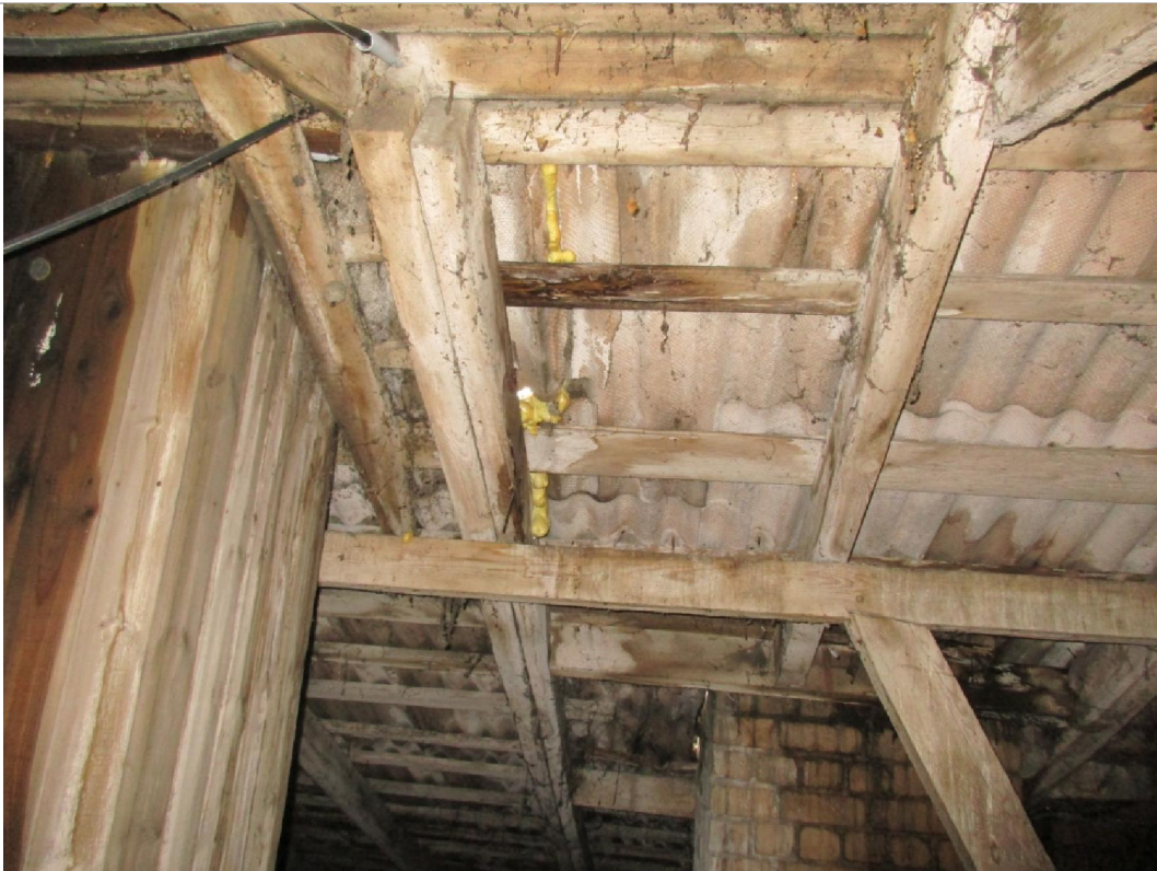
Jumta seguma neblīvumi atsevišķos apjomos aizdarināti ar montāžas putām, jumta segums nehermētisks.
